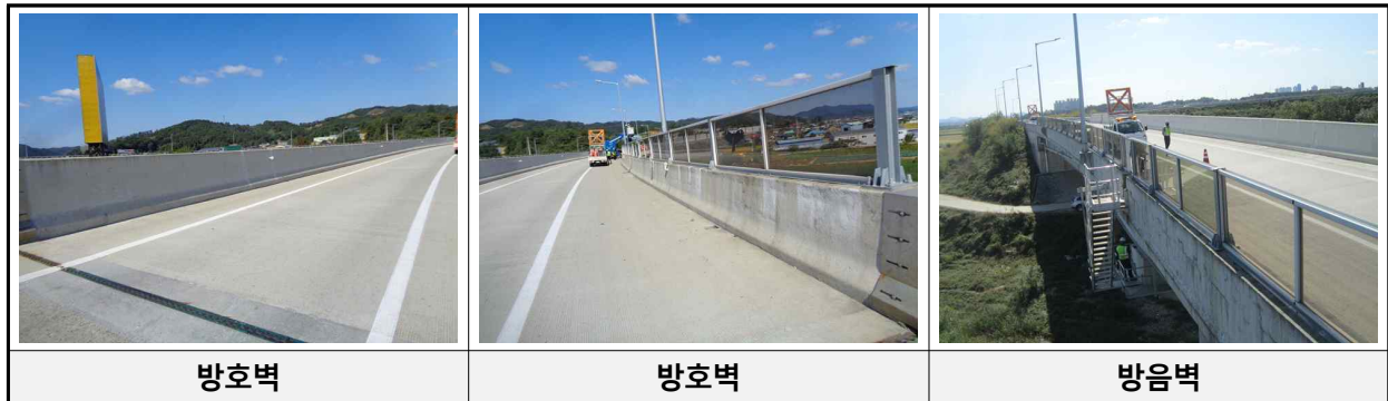
[방호벽 및 방음벽 전경]
