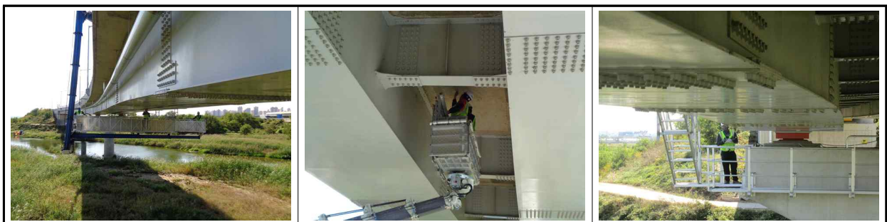
[고소작업차, 굴절점검차를 이용한 근접조사 실시]
