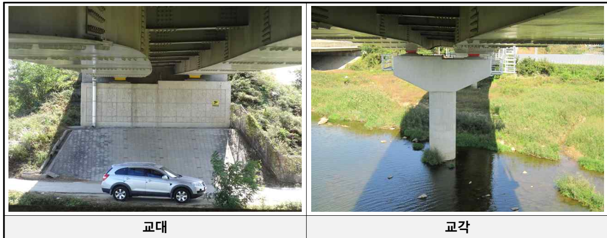
[교대 및 교각 전경]
